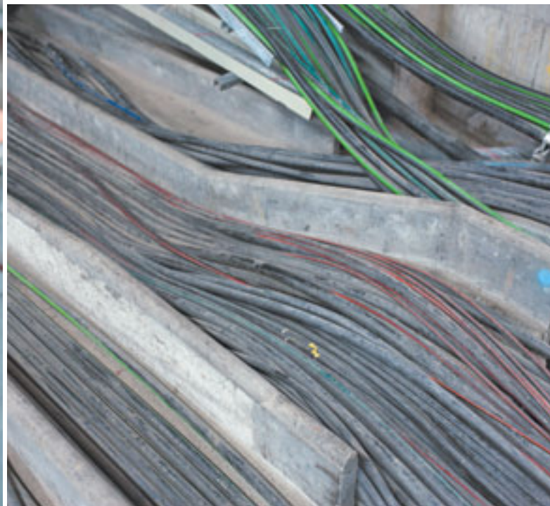
Bei der Arbeit im Gleisbereich ist die Sicherheit besonders wichtig (Bild oben). Das Nervensystem der SBB präsentiert sich unscheinbar (Bild unten)
