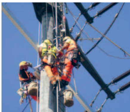
In luftiger Höhe: Vorarbeiten für die Verlegung der 132 kV-Leitung.
