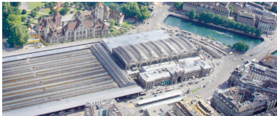
Der Kopfbahnhof Zürich. Unterirdisch entsteht der neue Durchgangsbahnhof.
