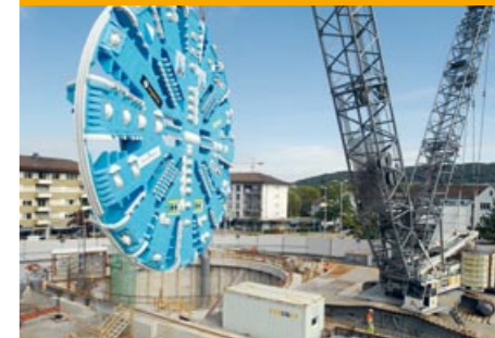
Das Schneidrad in luftiger Höhe.
